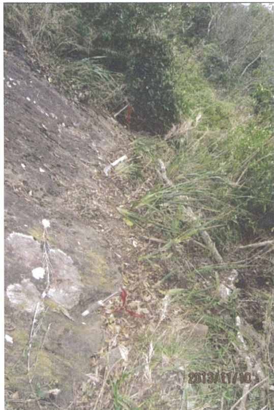
圖15 說明：梅園石壁隘勇棧道鋼筋孔穴（二）
