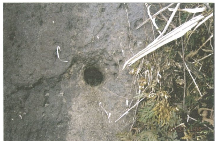
圖14 說明：梅園石壁隘勇棧道鋼筋孔穴（一）
