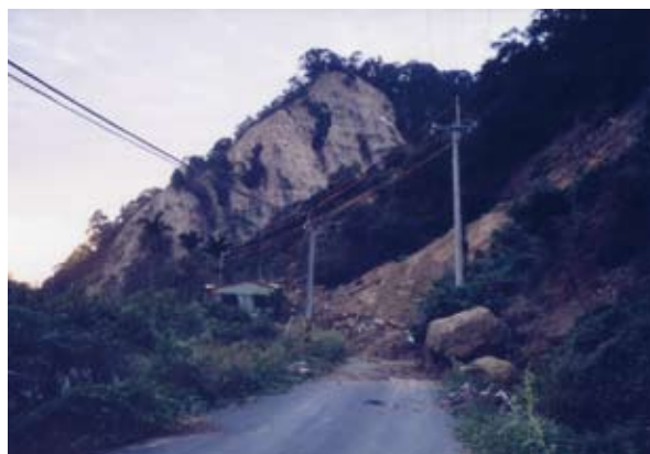
九二一地震山區農路損壞情形。(曾永富提供)
