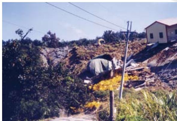
九二一地震風空農路損壞情形。(曾永富提供)
