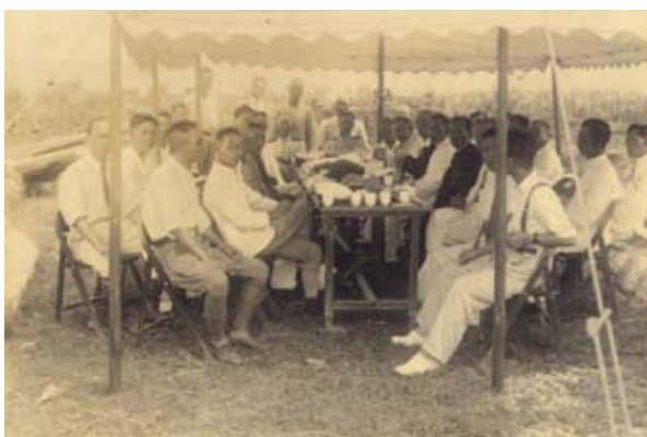
卓蘭堤防新建工程會勘。(詹益煌提供)
