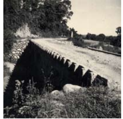
修復後的東茂橋。(謝國正提供)
