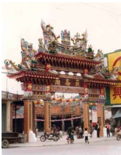
峩崙廟前舊牌樓現已拆除。 （峩崙廟提供）
