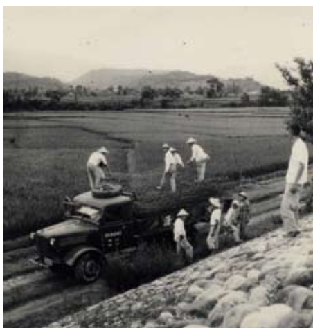
卓蘭堤防興建工程。 (詹益煌 曾永富提供)
