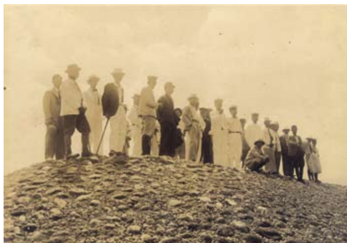
卓蘭堤防新建工程會勘。(詹益煌 曾永富提供)
