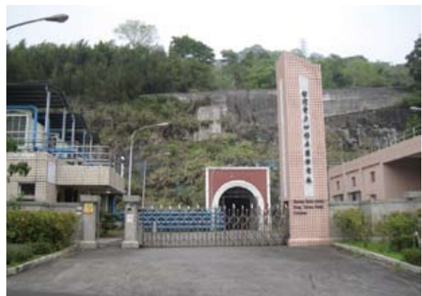
位於景山里地下的臺灣電力公司卓蘭發電廠。
