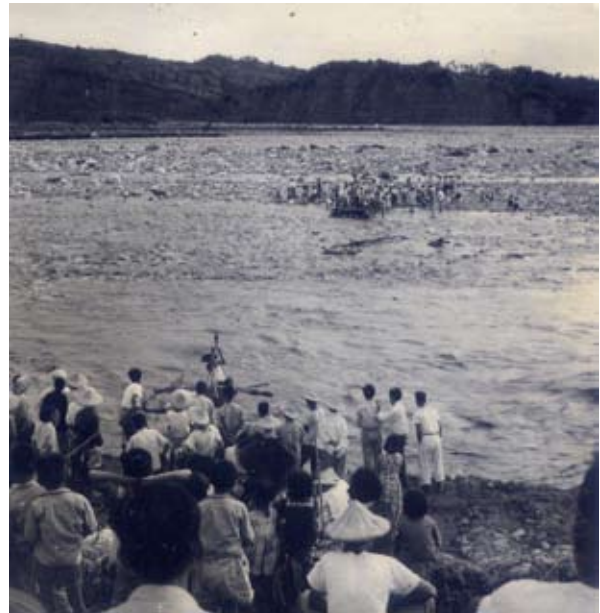
大安溪橋被洪水沖毀，民眾以「流籠」過大安溪。 (徐仲昌 曾永富提供)
