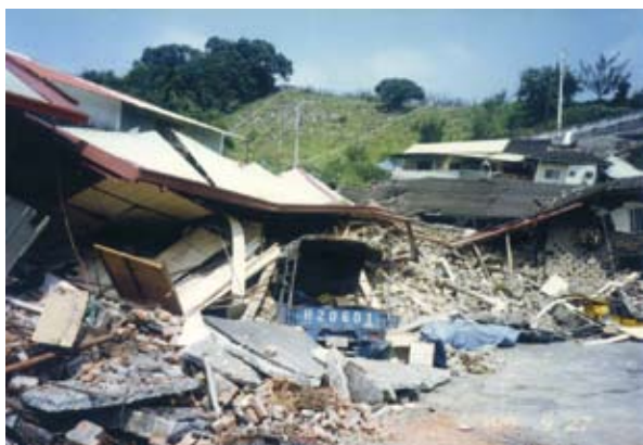
九二一地震上新民宅嚴重損壞情形。(曾永富提供)
