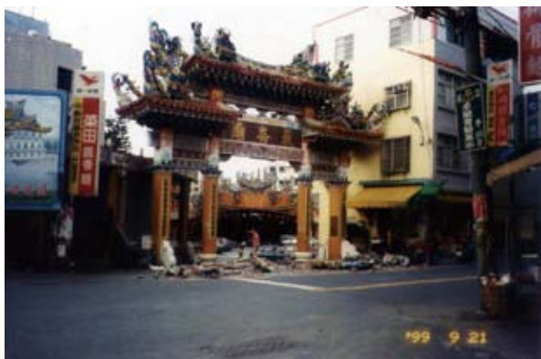
九二一地震我崙廟牌樓損壞情形。(曾永富提供)
