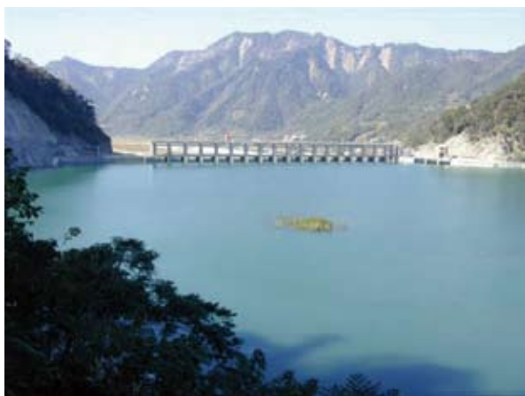
士林攔河堰。(卓蘭發電廠提供)
