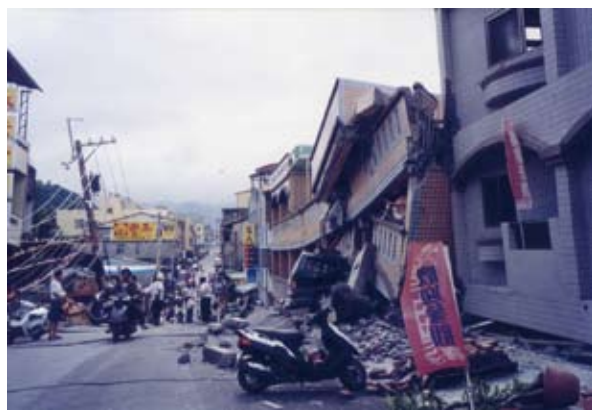
九二一地震內灣第7鄰民宅損壞情形。(曾永富提供)
