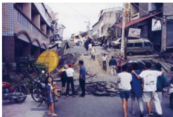
九二一地震內灣7鄰民宅及道路損壞情形。 (曾永富提供)
